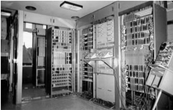
Mise en service du premier commutateur de ce type à Perros-Guirec: première mise en service en fin Janvier 1970 pendant 2 semaines puis retour sur le commutateur électromécanique et basculement définitif des abonnés sur PLATON le 13 Mars 1970 avec 800 lignes d'abonnés:
